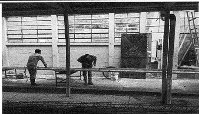
Foto1: Elaboración de estructura metálica del modulo 1.
