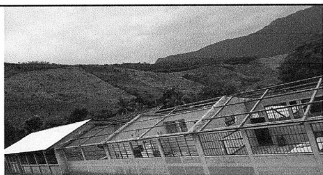
Foto 5: Estructura metálica instaladas 100%
