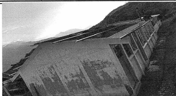
Foto 2: Instalación de estructura metálica del modulo 1
