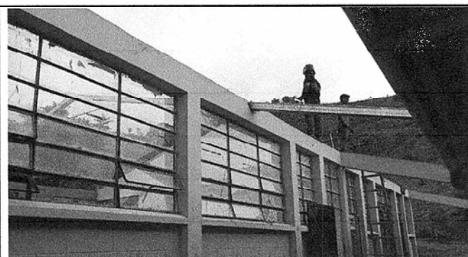
Foto 4: Instalación de estructura metálica del modulo 2
